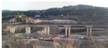
Figura 13. - Ladera y Viaducto de San Sadurní d'Anoia (Barcelona).
