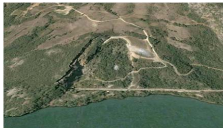
Figura 10. - Ladera Túnel 40 (Orense).
