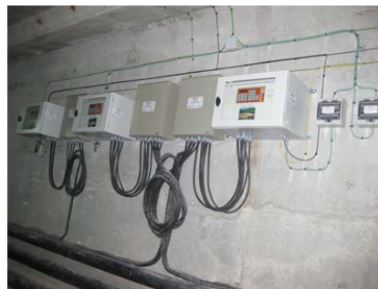
Figura 27. - Armarios Manuales y Estaciones Automáticas de Adquisición
