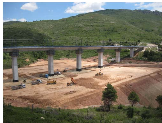
Figura 26. - Viaducto durante Fase I. Año 2010
