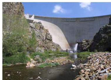
Figura 16. - Vistas panorámicas de la presa
