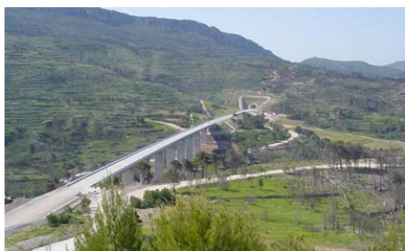
Figura 24. - Viaducto de Pont de Candí Año 2003
