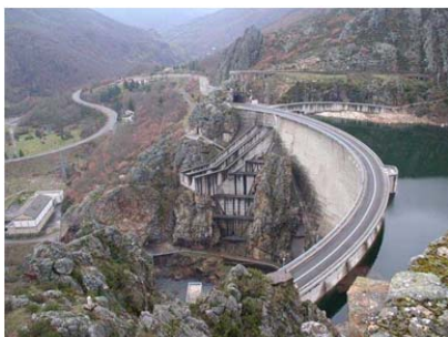
Figura 17. - Vistas panorámicas de la presa
