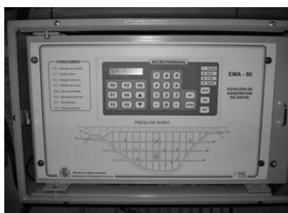
**Figura 22.** - Unidad de adquisición automática de datos
