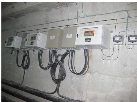
**Figura 30.** - Armarios Manuales y Estaciones Automáticas de Adquisición
